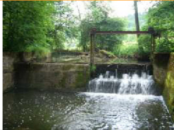
Wehr mit Falle ( \Delta H = 2m )
