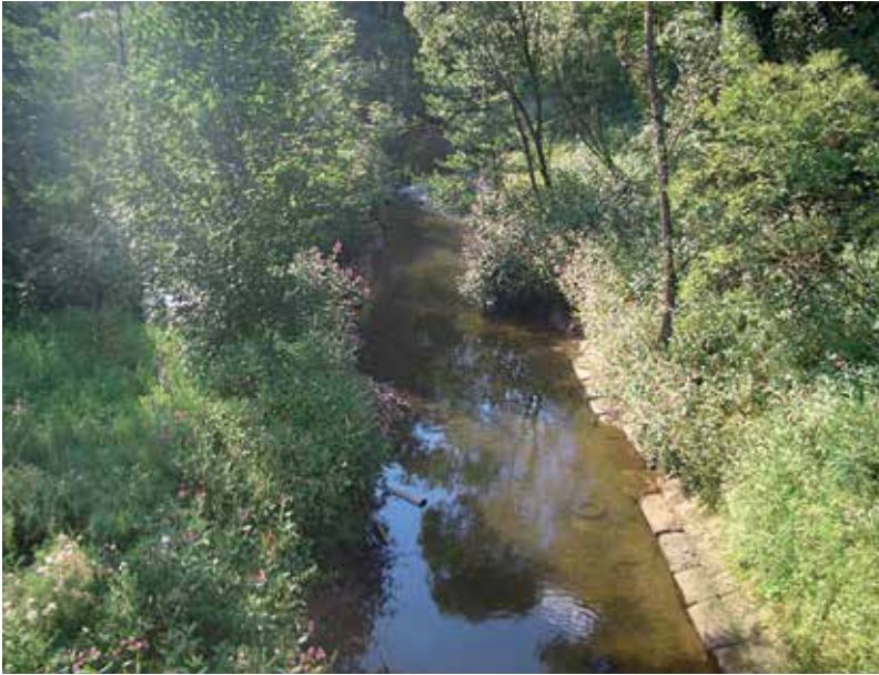
Stauraum der Rot bei Fichtenberg nach Absenkung
