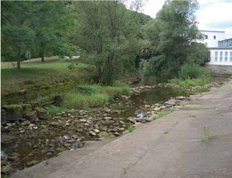
trockengefallene Ausleitung unterhalb des Wehres der WKA Stadtmühle in Schwäbisch Hall
