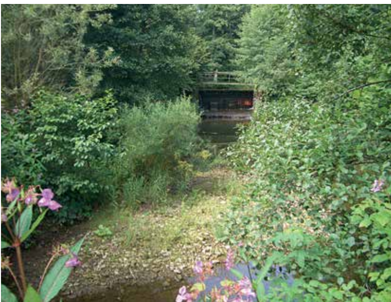
Trockengefallene Ausleitungsstrecke bei Oberrot. Kein Lebensraum für Fische
