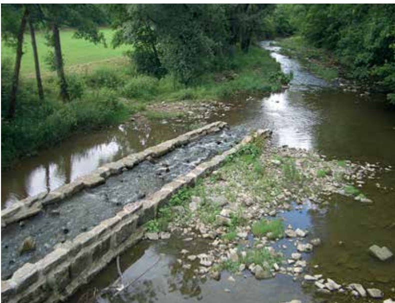
Fischaufstieg am Wehr in Wilhelmshück in der Ausleitungsstrecke
