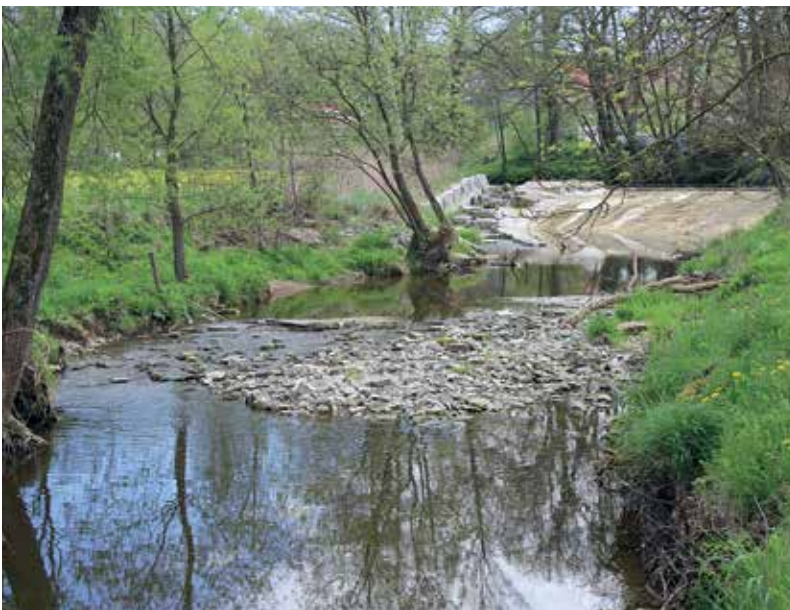
Fischpass mit Mindestwasserabgabe in Ausleitung in Eschenau
