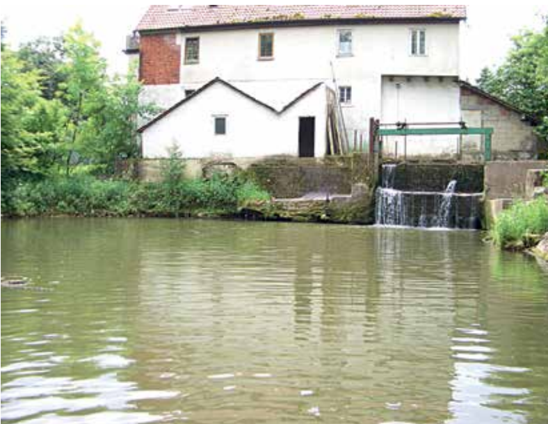
Wehr Kronmühle mit großem Pool bei Fichtenberg
