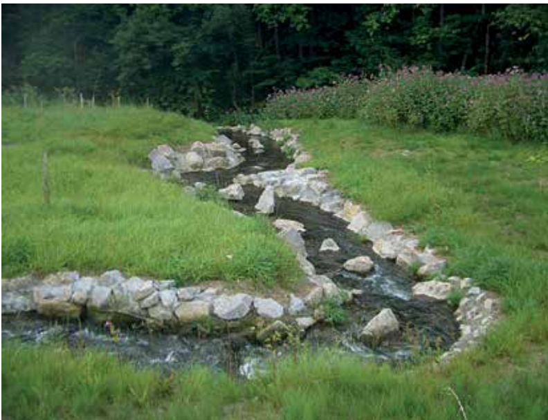
Fischaufstieg in Ausführung eines Umgehungsgerinnes an der Obermühle bei Oberrot
