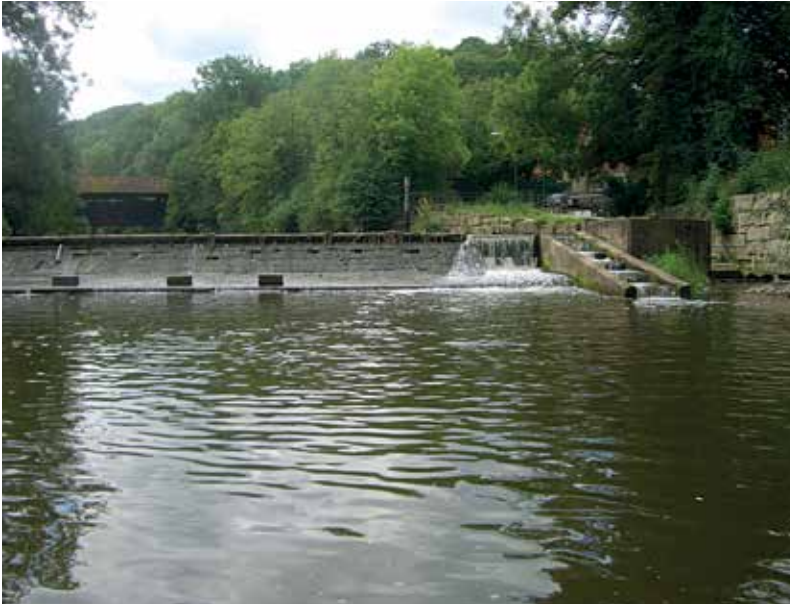
Kammerfischtrappe am Rippergwehr in Schwäbisch Hall → für Fische nicht durchwanderbar
