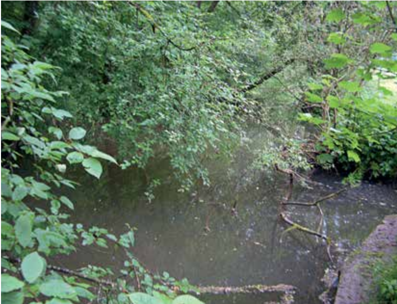
Totholzablagerungen im Stauraum der Scherbenmühle bei Wielandsweiler
