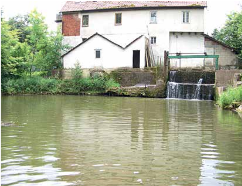
Wehr der Kronmühle bei Fichtenberg – kein Fischaufstieg vorhanden → unpassierbar für Fische
